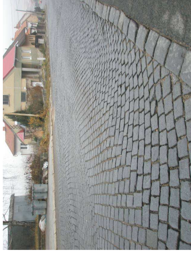
Trvalé deformace povrchu
