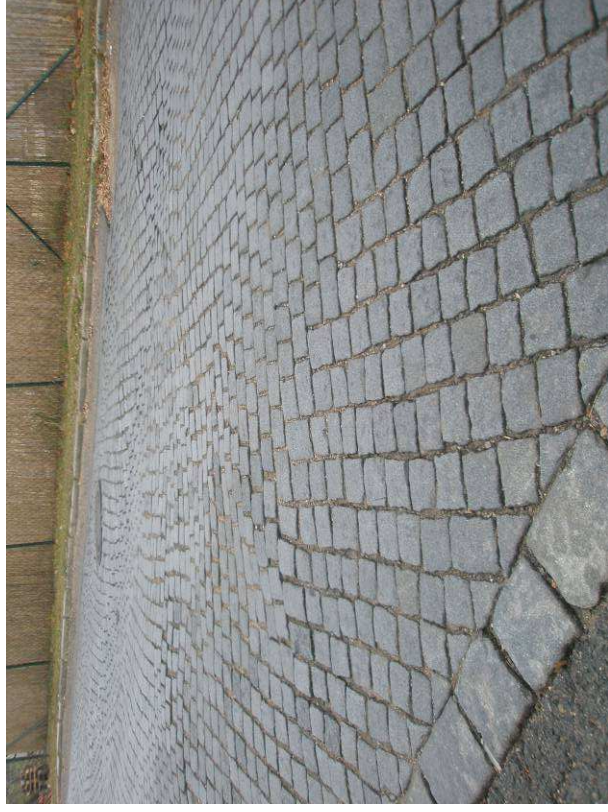
Trvalé deformace povrchu
