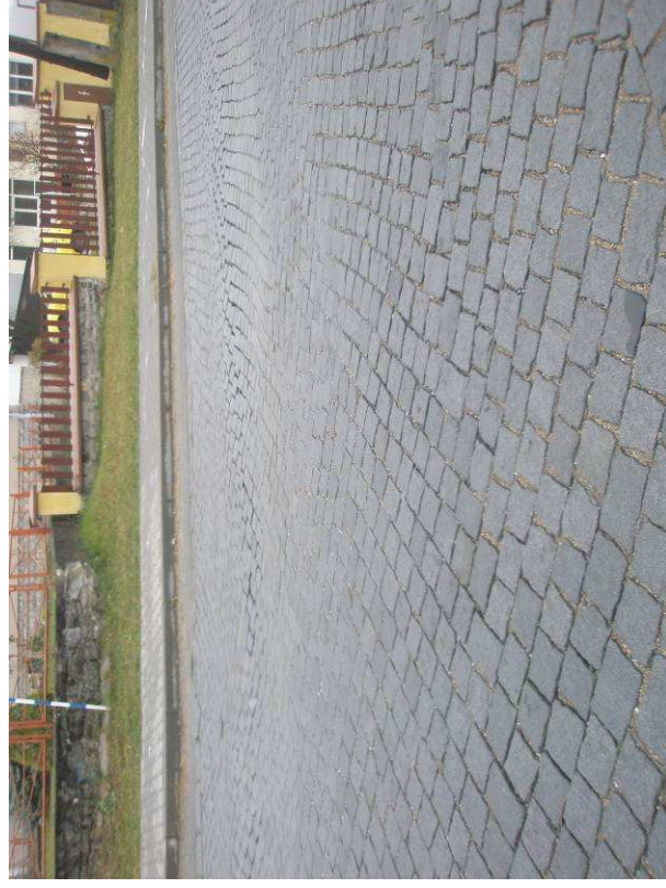
Trvalé deformace povrchu
